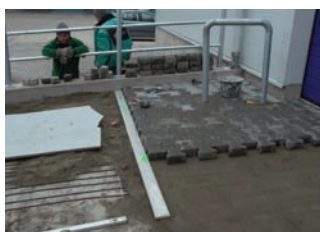
pokládka zámkové dlažby na vrstvu s topnými kabely
