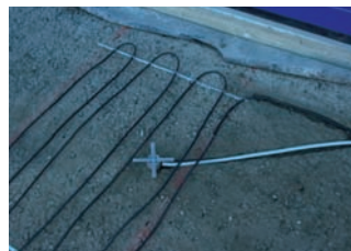
instalace vlhkostního čidla
