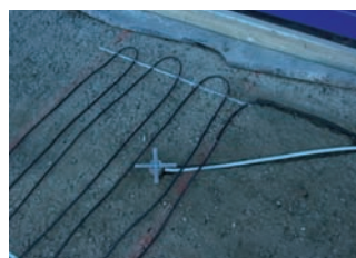
instalace vlhkostního čidla
