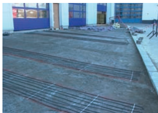
instalace topných kabelů pomocí ocelových pásek GRUFAST
