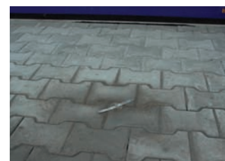
čidlo ETOG-55 v zámkové dlažbě
