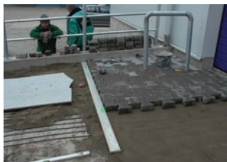
pokládka zámkové dlažby na vrstvu s topnými kabely
