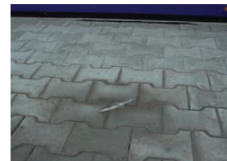
čidlo ETOG-55 v zámkové dlažbě
