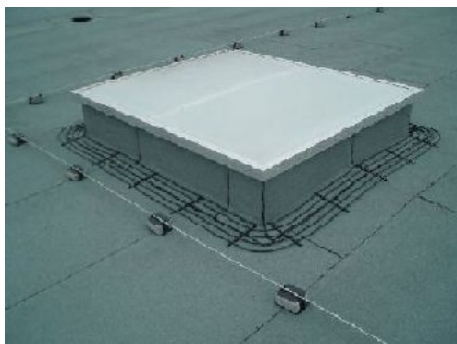
Instalace topných kabelů okolo světlíku
