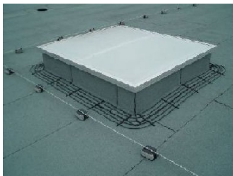
Instalace topných kabelů okolo světlíku
