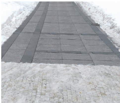
zabezpečení chodníku proti náledí, Praha
