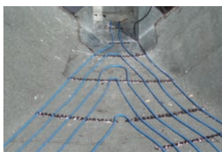
instalace topných kabelů v úžlabí střechy
