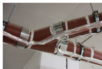
instalace topného kabelu na ochranu potrubí proti zamrznutí
