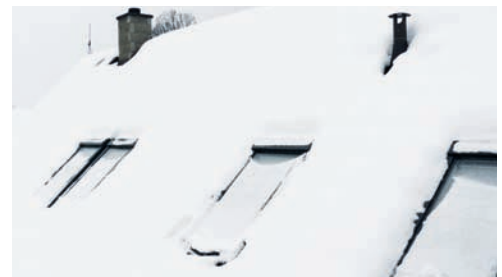
přimrzlá střešní okna, střední Čechy
