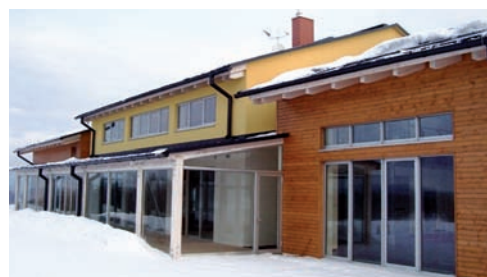
nebezpečné přístupové chodníky do objektů, Liberec
