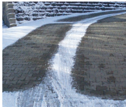
vyhřívání jezdové pásy, střední Čechy
