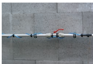
instalace topného kabelu PPC na potrubí před jeho zaizolováním
