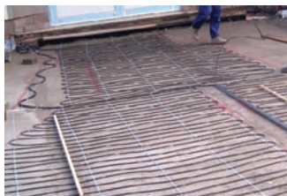
instalace topných kabelů na vyhřívání venkovní plochy
