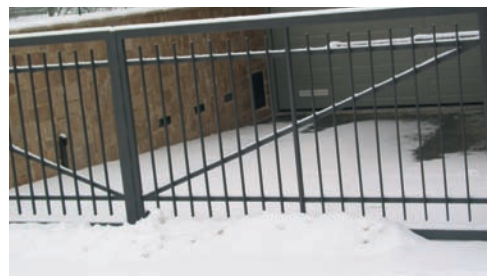
zamrzlé a zasněžené pojezdové kolejnice vrat a bran, nesjízdný výjezd z garáže, Praha
